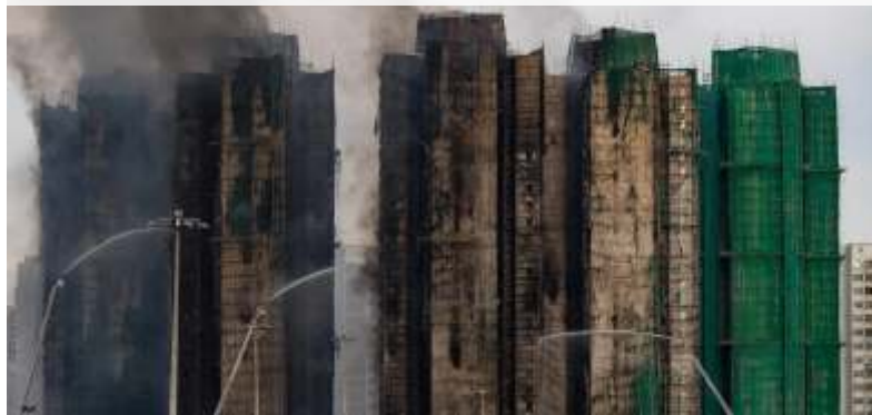
Petugas pemadam kebakaran memadamkan kebakaran yang terjadi sejak hari Rabu di Wang Fuk Court. Tampak kompleks perumahan di distrik Tai Po, Wilayah Baru Hong Kong, tersebut hangus, Kamis (27/11/2025). (AP)
