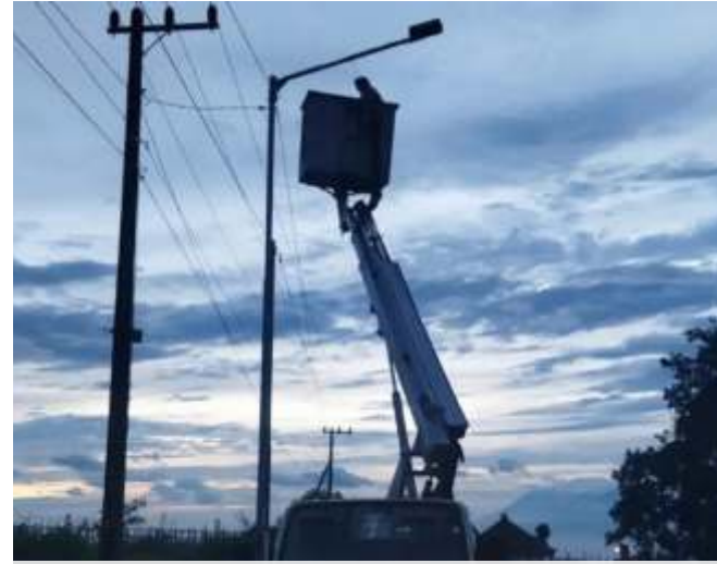
Ilustrasi: Pemeliharaan rutin penerangan jalan umum (PJU) di Kabupaten Malang. (dok:ist/Dinas PU Bina Marga Kab. Malang)
